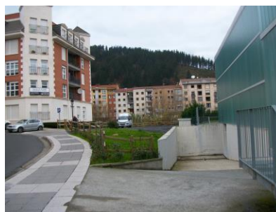
Fachada lat izquierda
